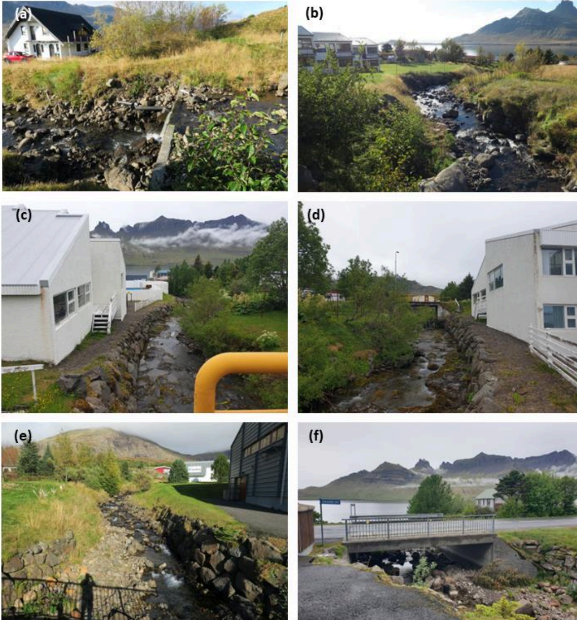
Mynd 16. Farvegur Einarstaðaár innri niður í gegnum þéttbýlið. (a) Lítil stífla efst í þéttbýlinu. (b) Horft niður farveginn ofarlega í þéttbýlinu. (c) Skólinn og sundlaugin þar fyrir neðan. (d) Horft upp farveginn við skólann. (e) Horft frá neðri brúnni upp eftir árfarveginu. Fremst er íþróttahúsið og sundlaugin þar að baki. (f) Neðri brúin séð frá íþróttahúsinu.
