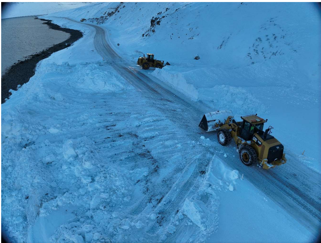
Mynd 6. Vinnuvélar hreinsa veginn um Súðavíkurhlíð eftir að snjóflóð féll á veginn.
