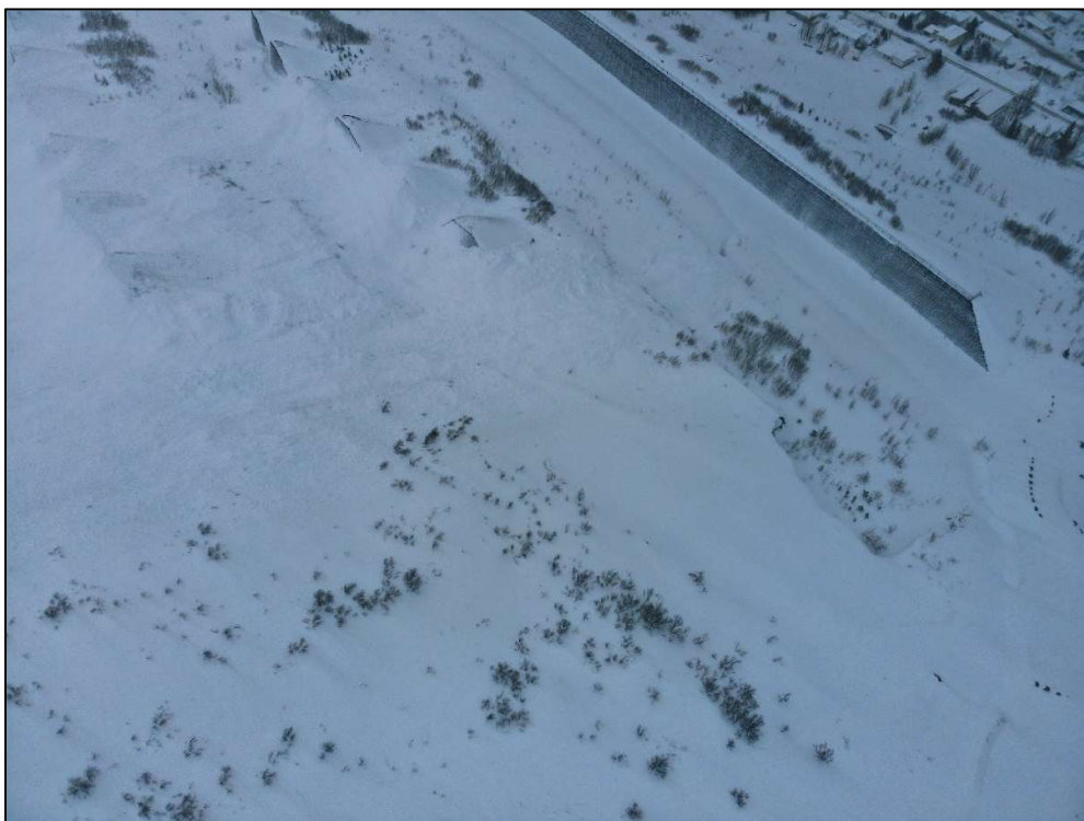
Mynd 42. Snjóflóðið lenti á varnarkeilum og þvergarði fyrir neðan.
