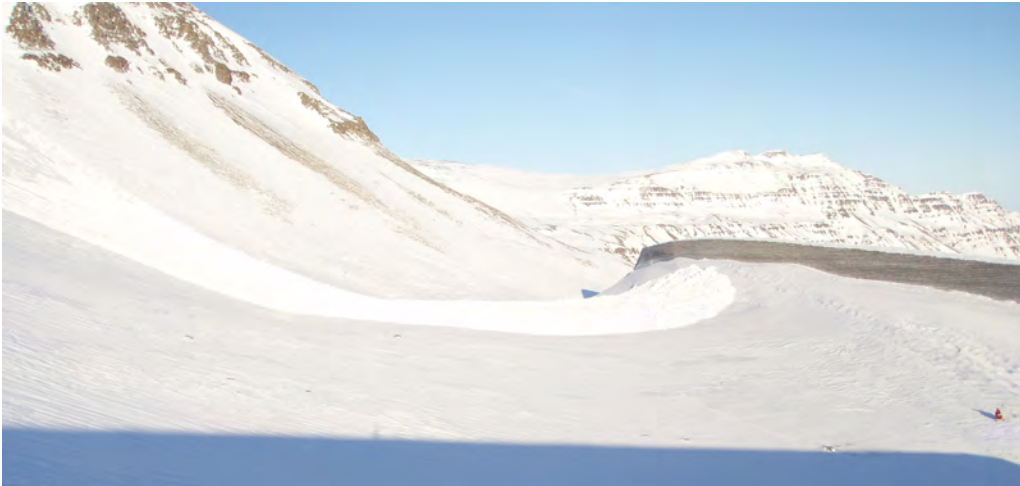
Mynd 2. Snjóflóð sem féll 9. febrúar 2008 úr upptakasvæðinu ofan Brúnar í Bjólfi og stöðvaðist við þvergarðinn á Brún. Garðurinn er alls 20 m hár, með 10 m háu þverhníptu stáli efst. Sjá má mann á vélsleða neðarlega til hægri á myndinni. Ljósmynd: Emil Tómasson, 10.2.2008.
