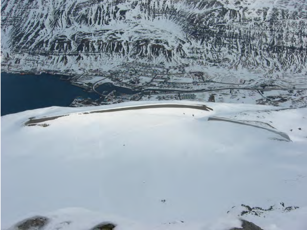
Mynd 5. Varnargarðar á Brún í Bjólfi. Þvergarður er fyrir miðri mynd og leiðigarður til hægri á myndinni. Báðir garðarnir eru 20 m háir með 10 m háu þverhníptu stáli efst. Ummerki eftir snjóflóð sem féll 5.–9. apríl 2006 og fór að hluta til yfir þvergarðinn sjást á bratta hluta garðsins. Fjær má sjá byggðina undir Botnabrún og innri hluta Strandartinds. (ljósmynd: Tómas Jóhannesson.)
