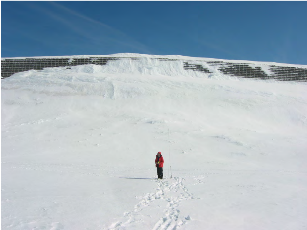
Mynd 3. Ummerki um snjóflóð sem féll 5.–9. apríl 2006 úr upptakasvæðinu ofan Brúnar í Bjólfi og rann að hluta yfir varnargarðinn á Brún. Garðurinn er 20 m hár með 10 m háu þverhníptu stáli efst. Snjóflóðið hnoðaði snjóþrygju utan á stálgrindur sem mynda þverhnípta hluta garðsins þar sem það fór yfir garðinn. Ljósmynd: Tómas Jóhannesson, 14.4.2006.
