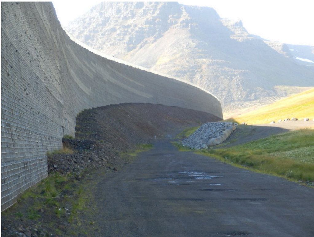
Mynd 1. Stærri varnargarðurinn undir Traðarhyrnu við Bolungarvík er 22 m hár þar sem hann er hæstur og hliðin sem snýr upp í fjallið er brött. Ljósmynd úr myndasafni sem fylgir varnargarðaskýrslu Eflu o.fl. (2017).
